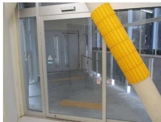
【図 2-5-4 緩衝材設置個所】
